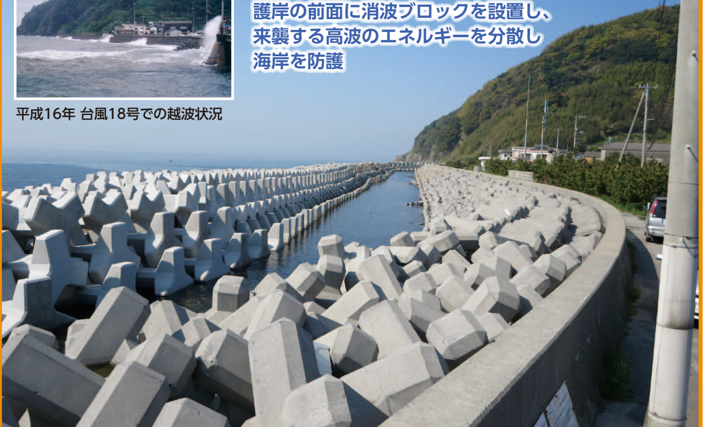
海岸高潮対策工事後
