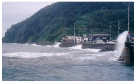
平成16年 台風18号での越波状況
