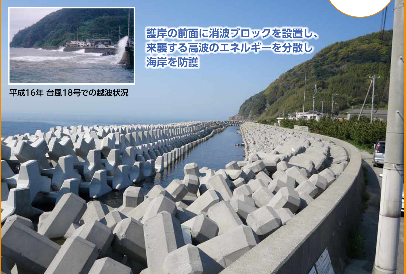
海岸高潮対策工事後
