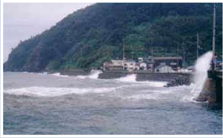
平成16年 台風18号での越波状況
