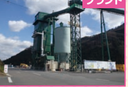
▲この建物の中で生コンが作られているんだよ
