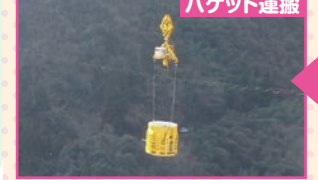
▲バケットをケーブルクレーンで運んで...
