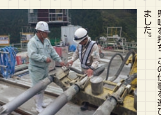
▲この建物の中で生コンが作られているんだよ
