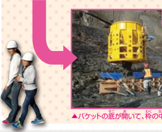
▲バケットの底が開いて、枠の中に生コンを流し込むよ
